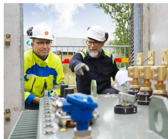
Martin Carlsson och medarbetare från leverantören Kraftmontage kontrollerar installationen i nätstationen.
