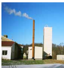
NÄRVÄRME ULLARED, VESSIGEBRO
