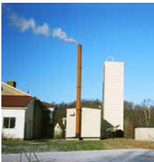
NÄRVÄRME ULLARED, VESSIGEBRO
